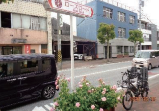
案内路面標示設置工事
