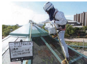
パーゴラの改修
