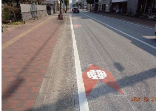
案内路面標示設置工事 (矢羽根型)
