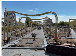
アーチ(大)の設置
