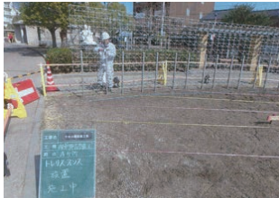
フェンスの設置
