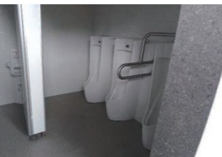
ふれあい広場便所改修工事 (男性用)
