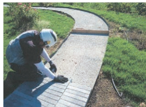
インターロッキング据付
