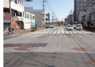
道路舗装工事(千田一文字幹線)
