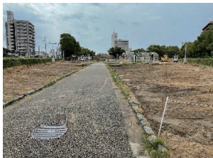
土木整備工事
