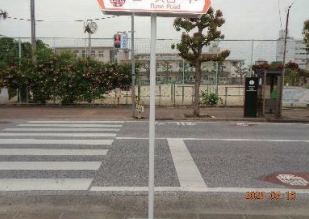
案内路面標示設置工事
