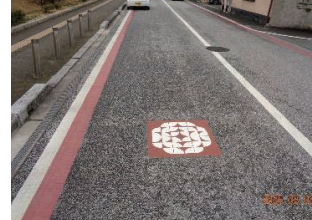
案内路面標示設置工事 (車道路面標示)
