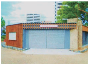
ばらハウス設備修繕
