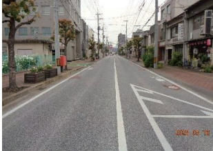
道路舗装工事(霞光南線)
