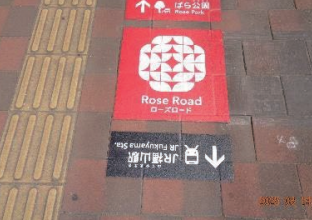
案内路面標示設置工事 (歩道路面標示)
